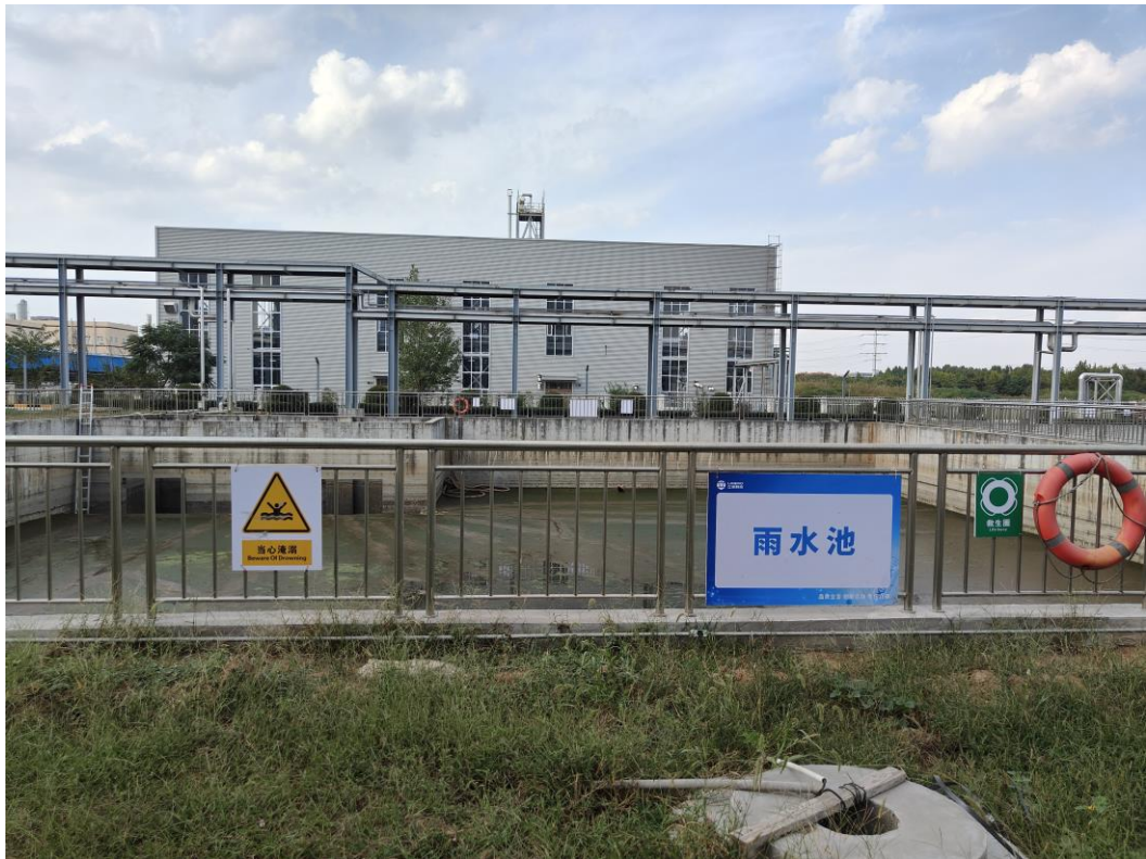
初期雨水收集池
